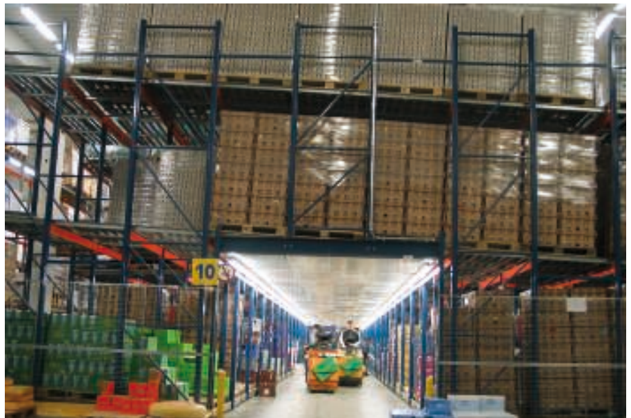
Bild 3 Blick in einer der beiden 50 m langen Kommissioniertunnel. Darüber spannen sich in zwei Ebenen Palettendurchlaufregale mit durchgehenden Kanälen.
