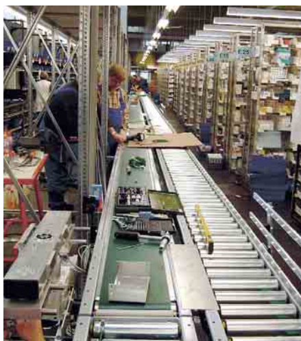
Während der Bauphase, 1. Kommissionierstrecke (Bilder: Rema Tec)
