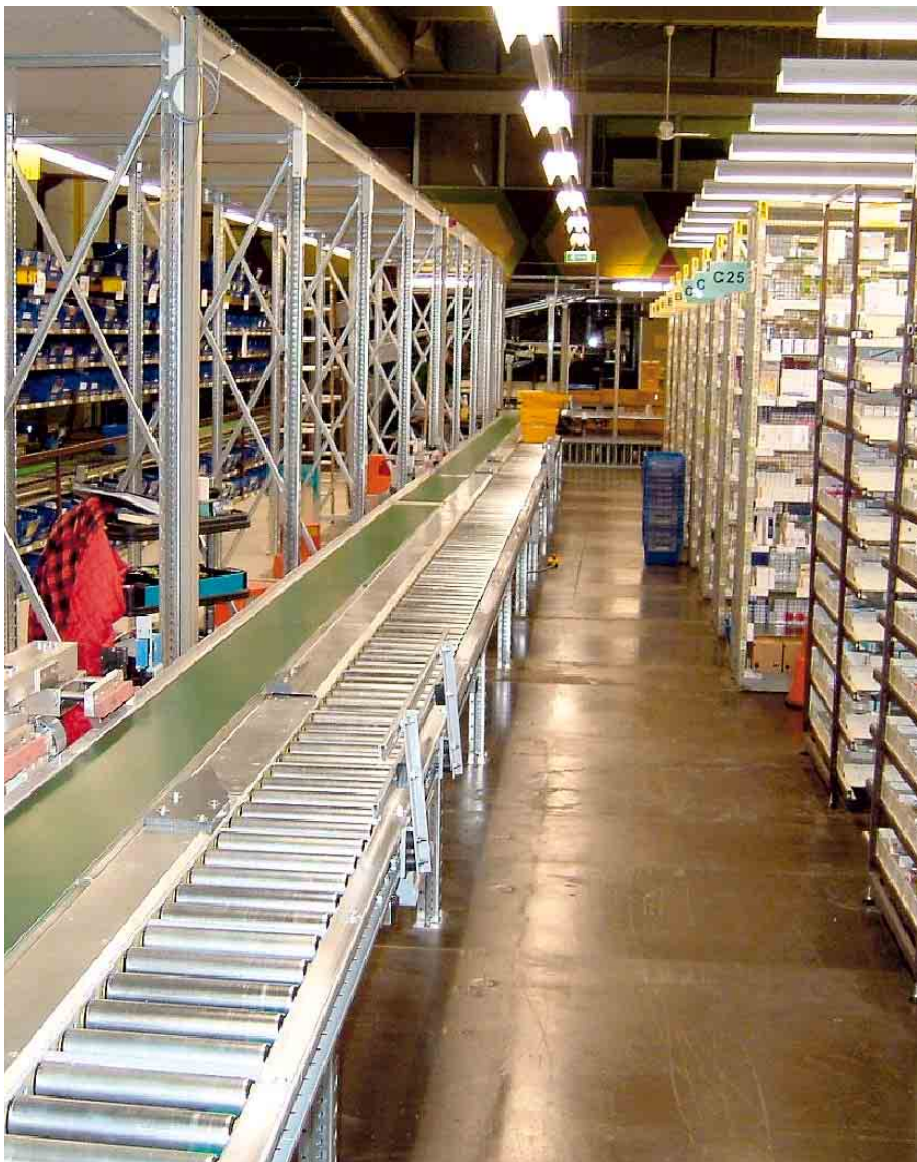
Kommissionierstrecke, 1. Bauabschnitt, Durchlaufregale noch nicht montiert
