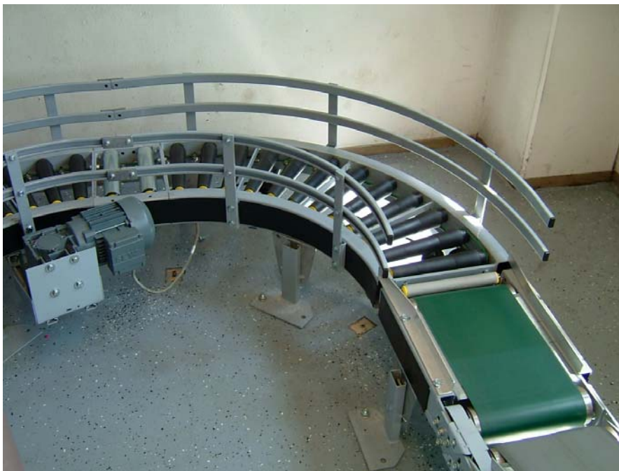
Bild 1.4 Zufahrt zur Endkontrolle nach einem Brandabschnitt (EG-OG)
