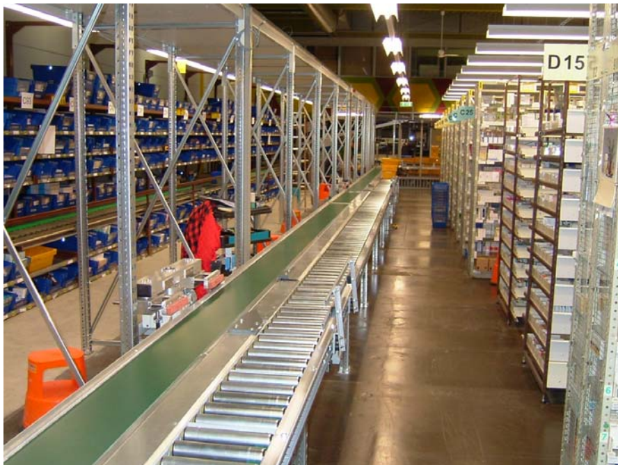
Bild 1.2 Kommissionierstrecke 1. Bauabschnitt, Durchlaufregale noch nicht montiert
